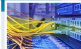
Systémy pro správu budov POWERBM/SSB
