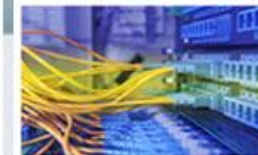
Systémy pro správu budov POWERBM/SSB
