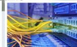
Systémy pro správu budov POWERBM/SSB
