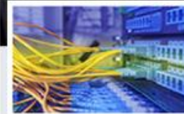
Systémy pro správu budov POWERBM/SSB
