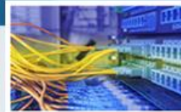
Systémy pro správu budov POWERBM/SSB
