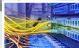
Systémy pro správu budov POWERBM/SSB
