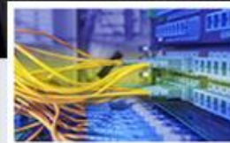
Systémy pro správu budov POWERBM/SSB
