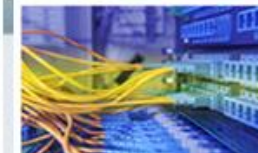
Systémy pro správu budov POWERBM/SSB
