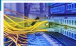
Systémy pro správu budov POWERBM/SSB
