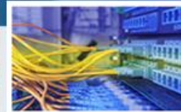
Systémy pro správu budov POWERBM/SSB
