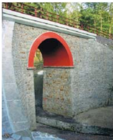
Příklad sanace cihelné přesypané klenby na trati ČD
