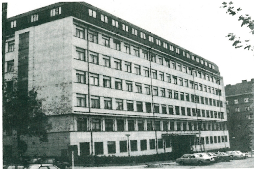
Budova NS ČR, Burešova 20
