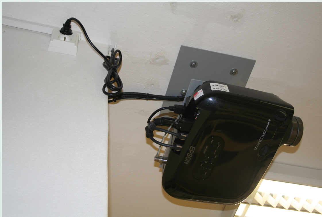
Obrázek 4: Zabezpečení HD projektoru proti krádeži (Kensington lock) atd.
